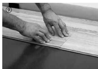
La lame est abaissée à l'about. Veuillez à cet égard que la lame soit glissée sur l'about aux abords de l'arête de la lame posée précédemment. En appuyant légèrement sur le chant transversal, la lame s'enclenche.
