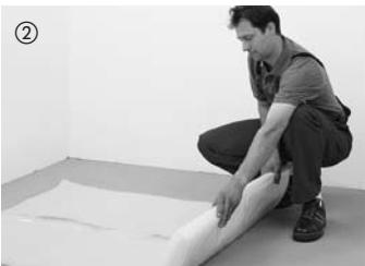
En règle générale, il faut toujours poser un film en polyéthylène de 0,2 mm d'épaisseur sur toutes les chapes et lors d'une pose sur un chauffage au sol. Les raccords des couches de film doivent se chevaucher sur environ 30 cm. Relever le film sur le mur et le couper après le montage des plinthes sur l'arête supérieure de ces dernières.
