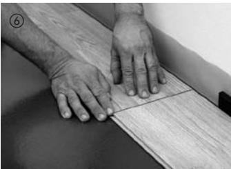
Les autres lames de la première rangée doivent être encliquetées par le haut au niveau des extrémités dans la lame précédente. En appuyant légèrement sur le chant transversal, la lame s'enclenche dans la lame voisine. Veuillez à respecter un alignement exact des lames. La dernière lame de la première rangée est coupée en respectant le jeu de dilatation de 10 à 15 mm par rapport au mur et emboîtée.
