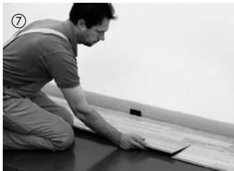
La deuxième rangée peut être commencée avec le reste de la première rangée (décalage des joints en bout d'élément d'au moins 50 cm). Ainsi on évite trop de chutes. Poser les autres lames les unes après les autres. Pour ce faire, les lames sont d'abord emboîtées sur la longueur sous l'effet d'une légère pression exercée dans la liaison.
