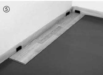
Pour commencer, poser les premières lames au coin droit de la pièce avec la languette côté mur et fixer à l'aide de cales biseautées (respecter un jeu de dilatation de 10 à 15 mm par rapport au mur).
