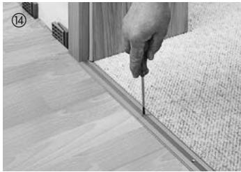
Un jeu de dilatation d'environ 5 mm sera respecté dans le profil. Le bas du montant de la porte doit être coupé avec une scie fine à hauteur de l'épaisseur de l'élément pour que le revêtement de sol stratifié puisse se dilater sous le montant. Une fois la pose terminée, il est impératif d'enlever les cales. Visser les plinthes (avec ou sans système à clips) au mur – c'est terminé !
