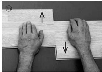
Pour déverrouiller les éléments, il est possible de les glisser en parallèle.
