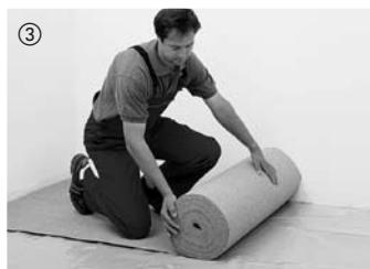
Pour l'isolation phonique et l'égalisation des petites aspérités, il convient de dérouler jusqu'aux bords un rouleau de liège de 2 mm d'épaisseur. D'autres sous-couches isolantes alternatives sont également disponibles parmi notre gamme d'accessoires. Le carton bitumé ne se prête pas à l'isolation phonique. **Pour les sols stratifiés HARO Silent Pro®, ne pas poser de sous-couche isolante supplémentaire.**
